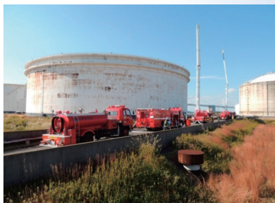
危険物火災対応訓練（コスモ石油（株）坂出物流基地）
